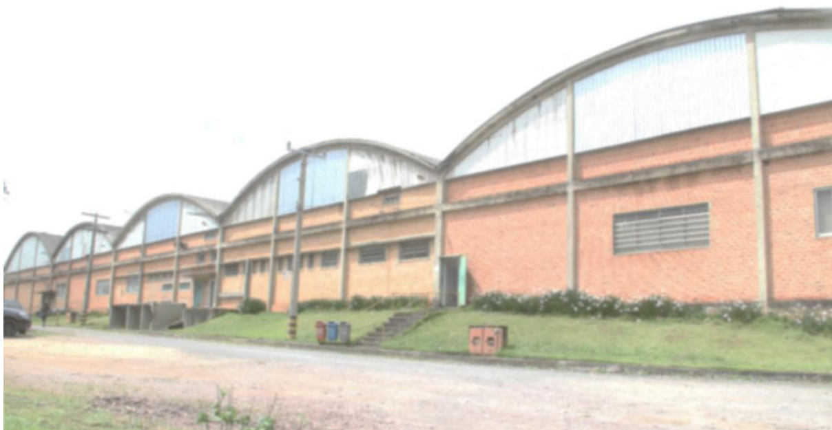
FIGURA 14 – FÁBRICA ORIGINAL DA MÓVEIS CIMO S.A - VILA NOVA, RIO NEGRINHO - SC. FONTE: A autora (2015).
