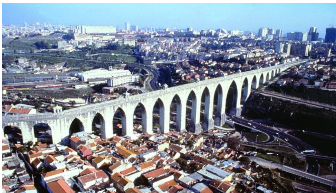
FOTO 6 - AQUEDUTO DAS ÁGUAS LIVRES
