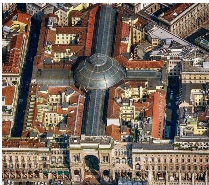
Vista de cima - Galleria Vittorio Emanuele II - Itália (Fonte: Itália Secreta)
