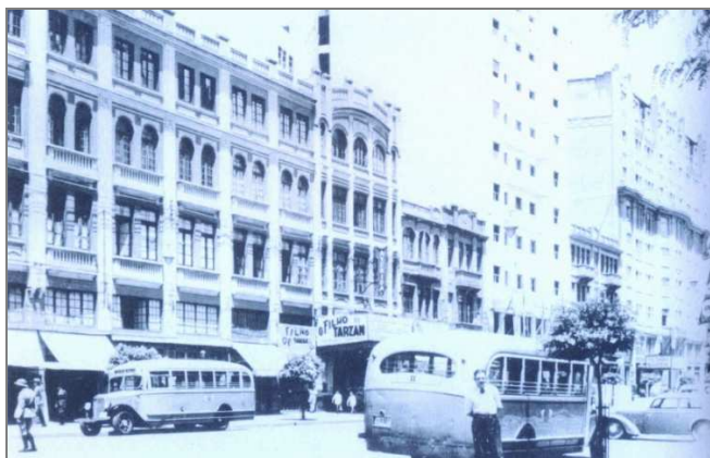
Figura 3 - Avenida Luiz Xavier-Cinelândia
