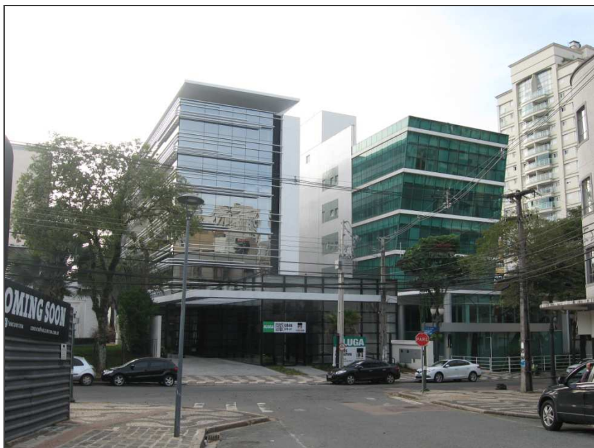
Figura 17 - Edifício Corporativo L'Hermitage – Batel
