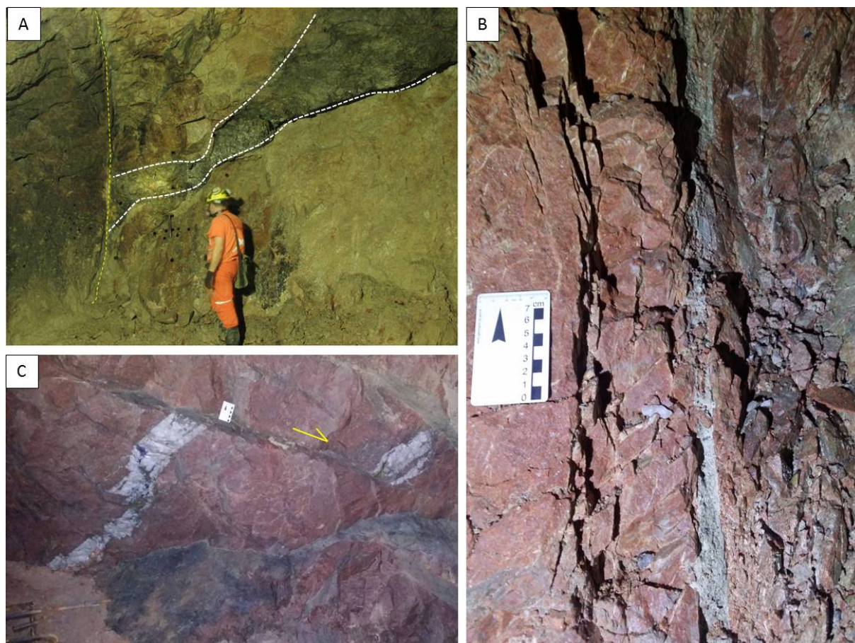
Figura 8: Planos de falha em quartzo sienitos da mina de ouro Tapiborã. A) Falha de direção NNW-SSE. Observar a interrupção do veio à esquerda do plano de falha. B) Detalhe do aspecto brechado do plano de falha. C) Exemplo de plano de falha normal de direção E-W, com rejeito um metro.
