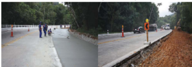
Esta etapa da obra terá início com a contenção de encostas
