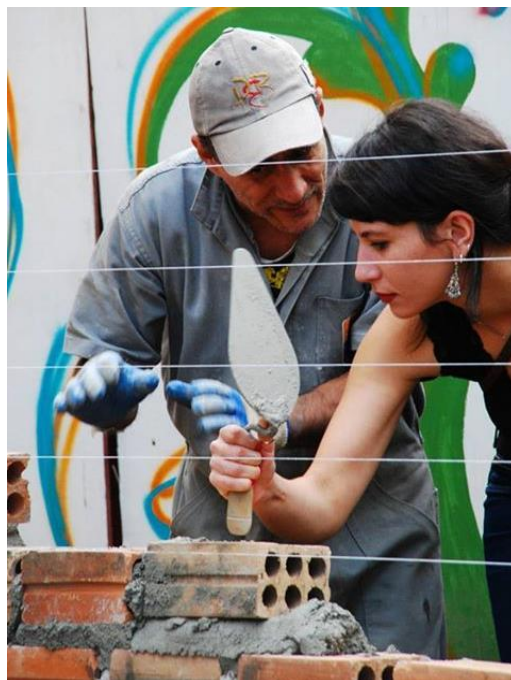
Figura 21 – Voluntário experiente em construção ensinando voluntária a assentar tijolos Fonte: Doug Oliveira – Rede Social PBC (2014)
