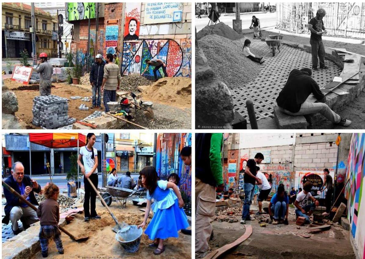
Figura 24 – Colocação do concregrama e do petit pavet
