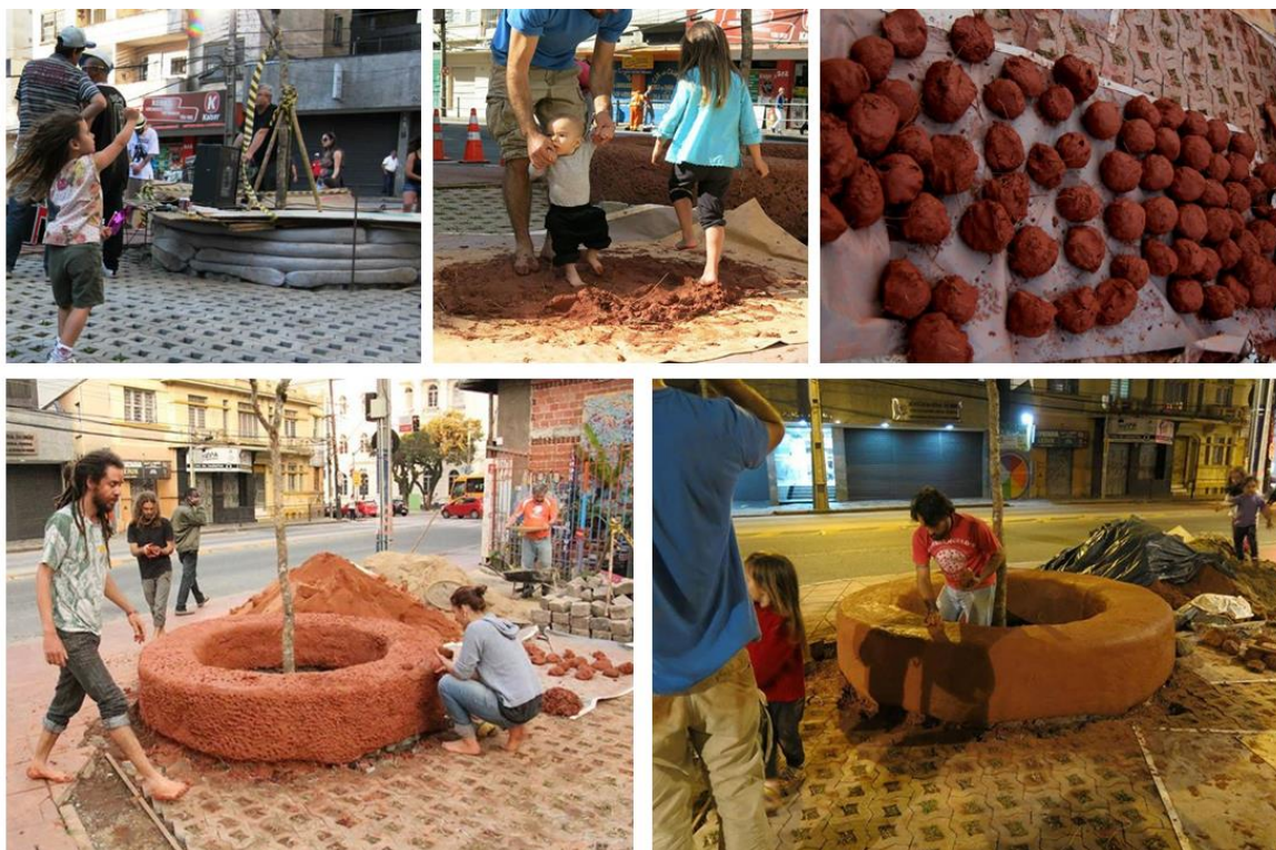
Figura 26 – Fases da construção do banco com a técnica do superadobe Fonte: Chaplin das Araucárias / Rafael Buratto – Rede Social PBC (2014)
