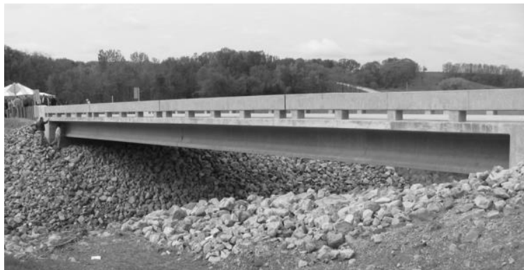
Figura 2.3 - Ponte pré-fabricada em CPR, Wapello Fonte: Graybeal (2006)
