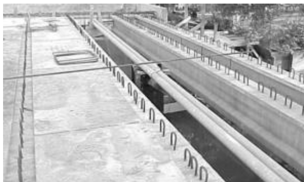
Figura 2.2 - Ponte Creek Road, Austrália
