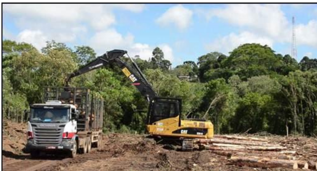
FIGURA 6 – DETALHES DO CARREGADOR FLORESTAL, ESCAVADEIRA FLORESTAL CAT 320D.
