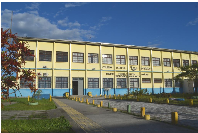
Figura 1 - Entrada principal de acesso à recepção. Fonte: Foto tirada pelo autor.
