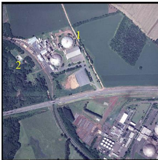
Figura 8. Vista aérea da indústria CARGILL, em destaque (1) ponto de lançamento de efluentes no rio Botuquara (2).
