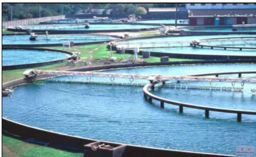
FIGURA 3 – Sistema de cultivo de microalgas Chlorella em lagoas circulares (Taiwan Chlorella Manufacturing Co. Ltd.)
