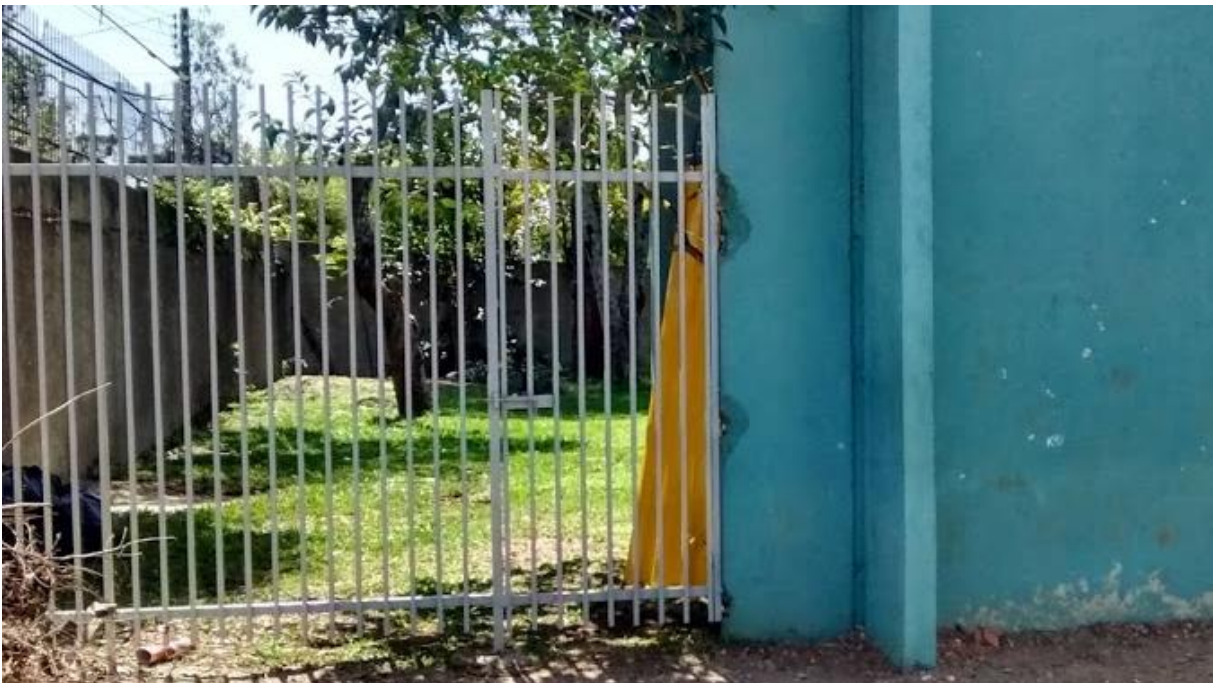
FOTOGRAFIA 11 - Portão mais largo (aproximadamente 1 metro) para facilitar o acesso de cadeirantes.
