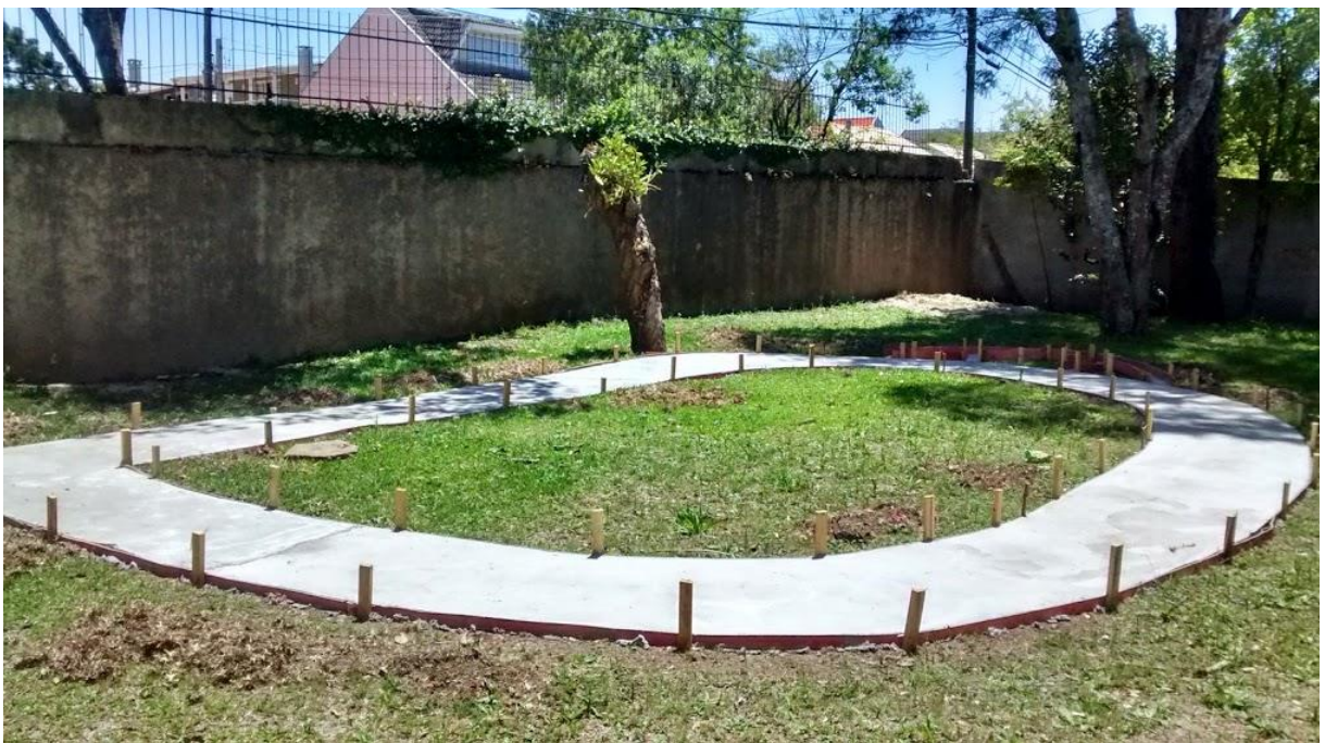
FOTOGRAFIA 9 - Calçada construída para permitir a acessibilidade.
