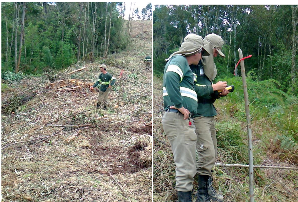
Figura 7 – Esquema de adequação ambiental em campo por equipes de topografia, com o uso de trena, estacas e coleta de dados por GPS Trimble em tempo real.
