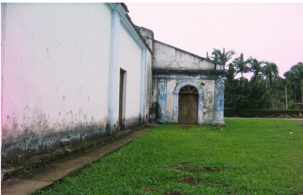
Figura 22A: Lateral da Igreja de São Sebastião do Porto de Cima Fonte: Acervo Pessoal – 2010
