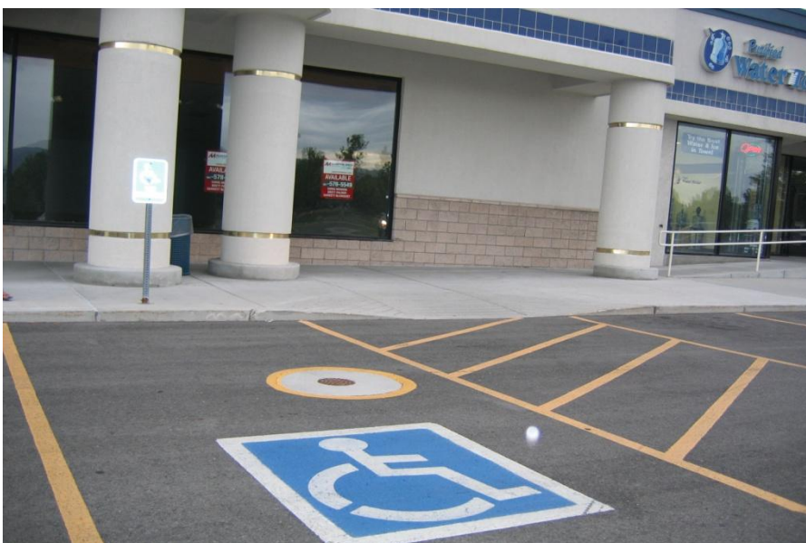
Figura 48: Vaga em estacionamento reservada para pessoa com deficiência. É possível observar calçada rebaixada ao fundo. Fonte: acervo pessoal -2010
