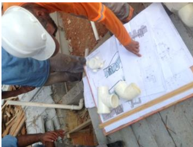
Figura 31 – mão de obra em contato com pranchas retiradas do modelo BIM
