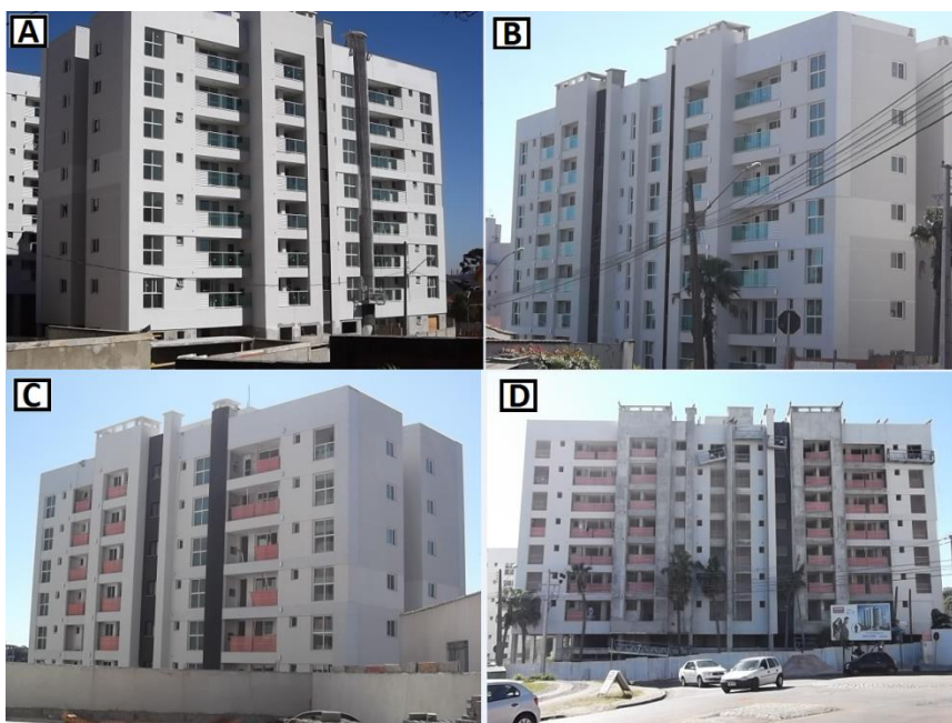
Figura 18 – Fotos do empreendimento C: (A) torre 1; (B) torre 2; (C) torre 3; (D) torre 4.
