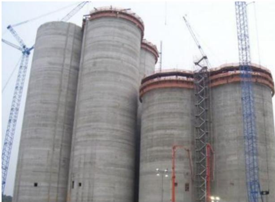
FIGURA 3: SILOS ELEVADOS DE CONCRETO
