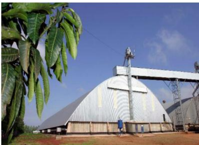
FIGURA 5: SILO HORIZONTAL OU ARMAZÉM GRANELEIRO
