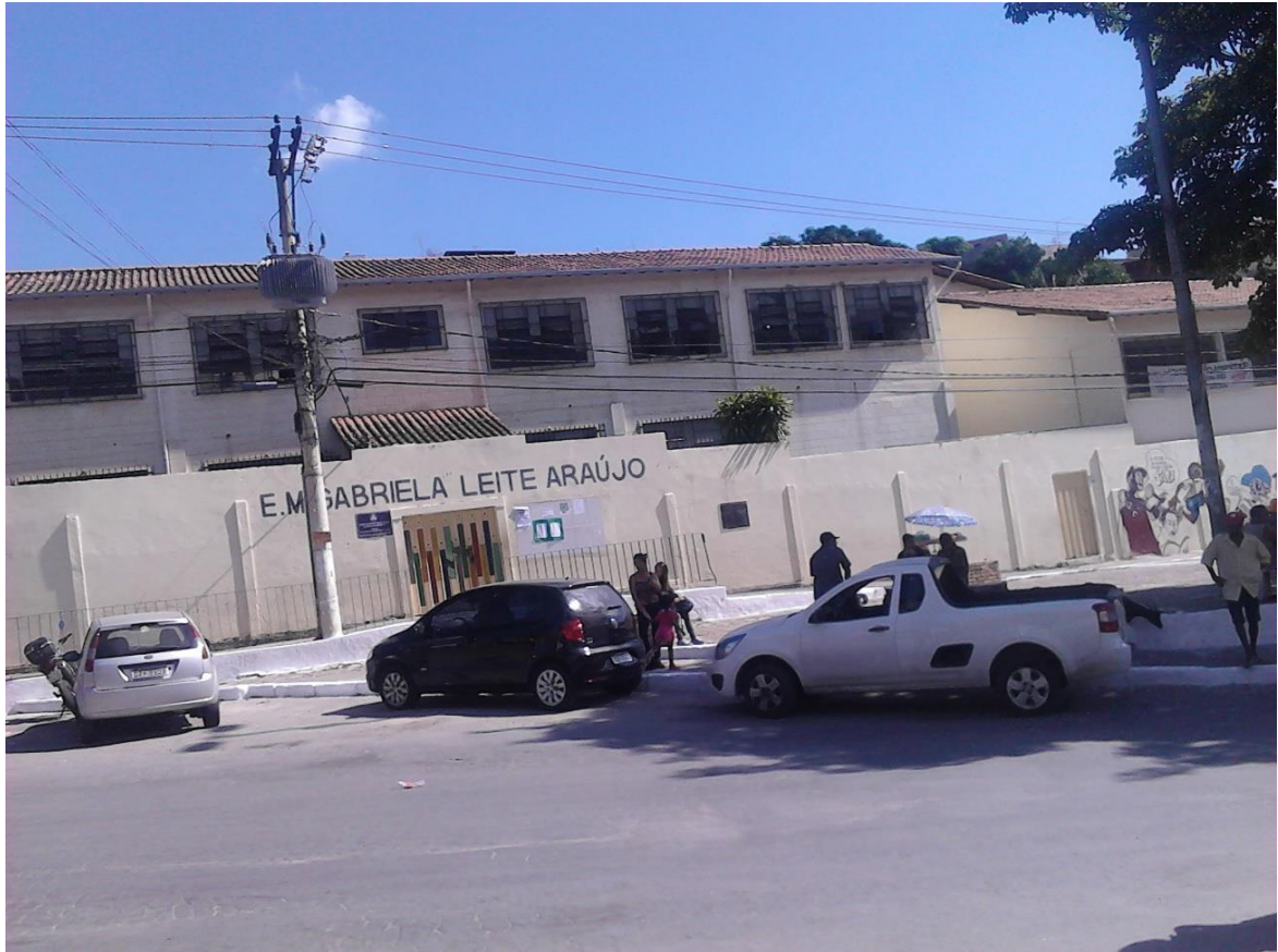
FIGURA 01 – Fachada da escola.
