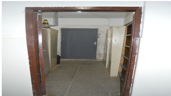
FIGURA 56 - ACESSO A QUADRA POLIESPORTIVA (CORREDOR)
