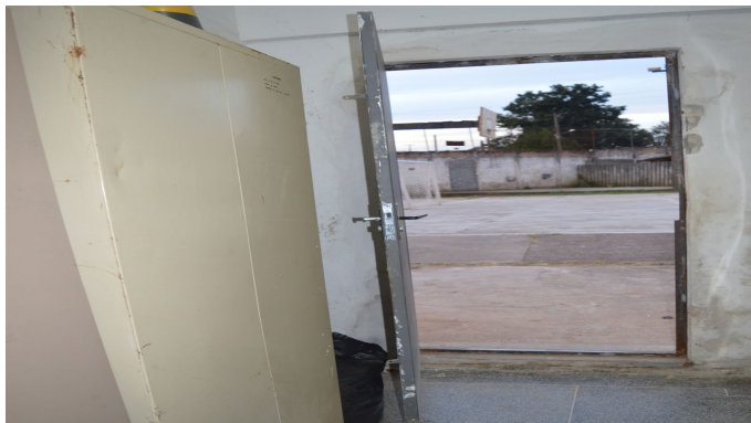
FIGURA 58 - ACESSO A QUADRA POLIESPORTIVA (PORTA) FONTE: O autor (2014)
