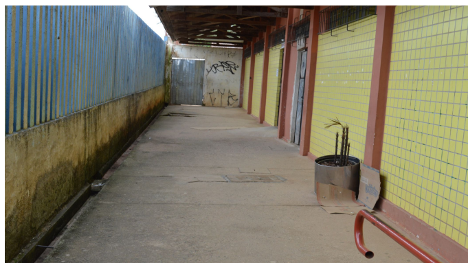
FIGURA 61 - CORREDOR DE ACESSO A SECRETARIA E A BIBLIOTECA FONTE: O autor (2014)
