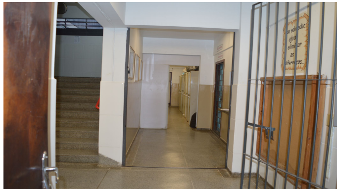
FIGURA 47 - CORREDOR DE ACESSO A SALA DOS PROFESSORES E AO LABORATÓRIO DE INFORMÁTICA.
