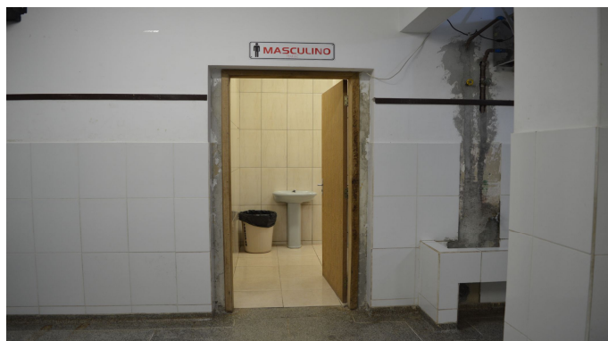
FIGURA 37 - ACESSO AOS BANHEIROS DOS ALUNOS FONTE: O autor (2014)
