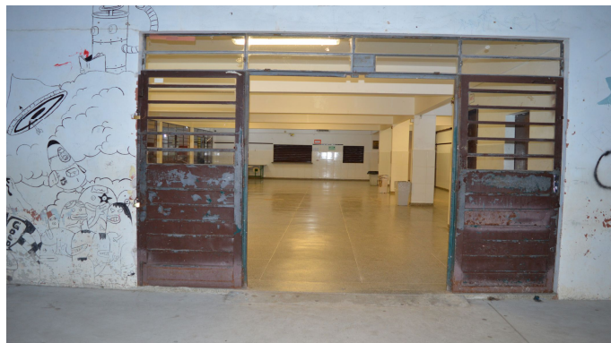
FIGURA 34 - ACESSO SAGUÃO – LADO DA RUA MARIA IZABEL TOSIN. FONTE: O autor (2014)
