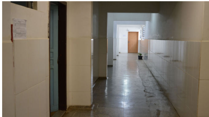
FIGURA 60 - CORREDOR DE ACESSO A SALAS DE AULA - TÉRREO FONTE: O autor (2014)
