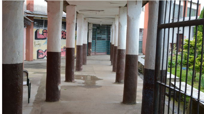
FIGURA 59 - CORREDOR DE ACESSO DA ENTRADA SECUNDÁRIA AO SAGUÃO/REFEITÓRIO FONTE: O autor (2014)
