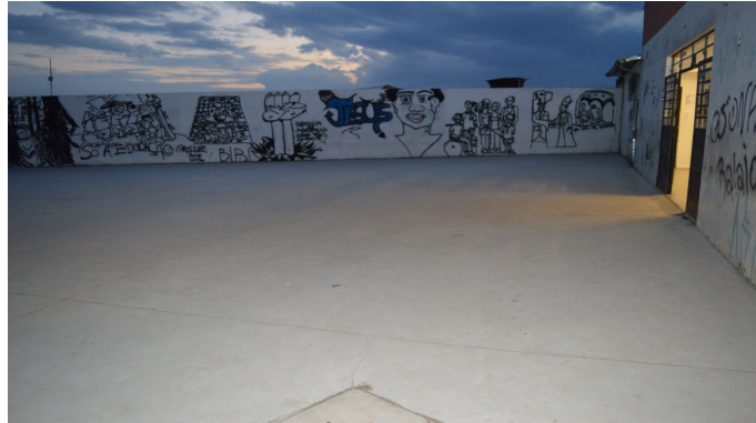
FIGURA 36 - PÁTIO – VISÃO LATERAL. FONTE: O autor (2014)
