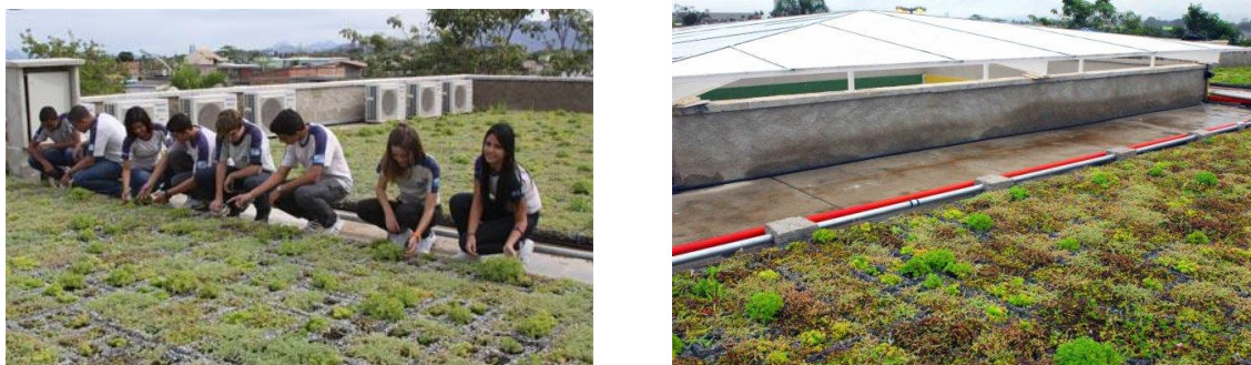
Figura 17 – Telhados verdes do Colégio Estadual Erich Walter Heine.
