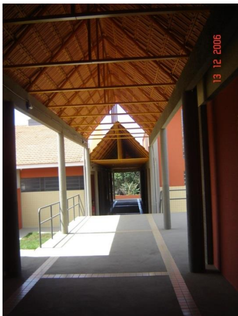
Figura 5 - Projeto padrão 023. Vista circulação central entre módulos.
