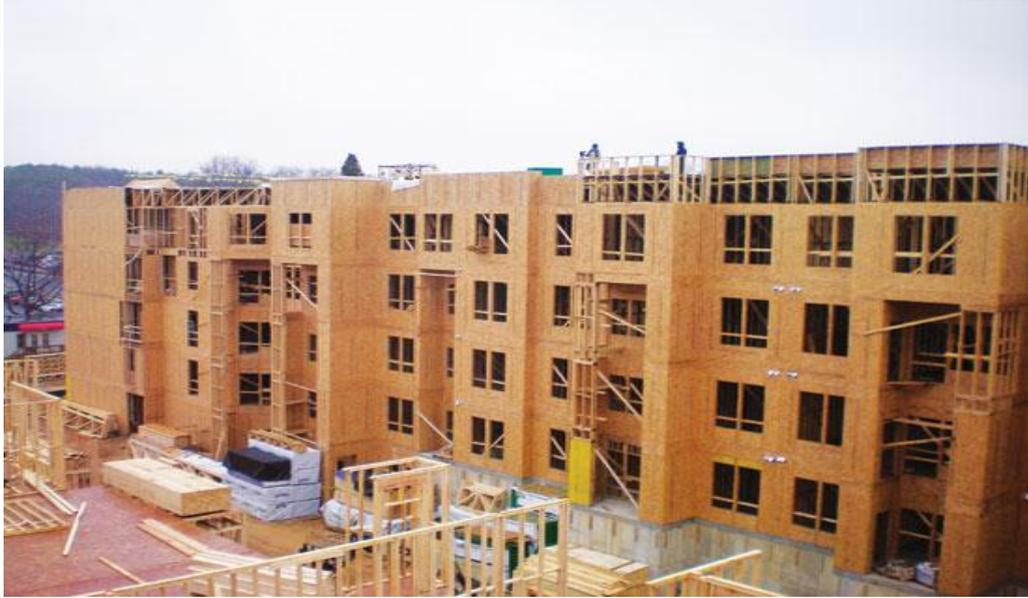
FIGURA 3 – EDIFÍCIO SENDO CONSTRUÍDO INTEIRAMENTE COM OSB.
