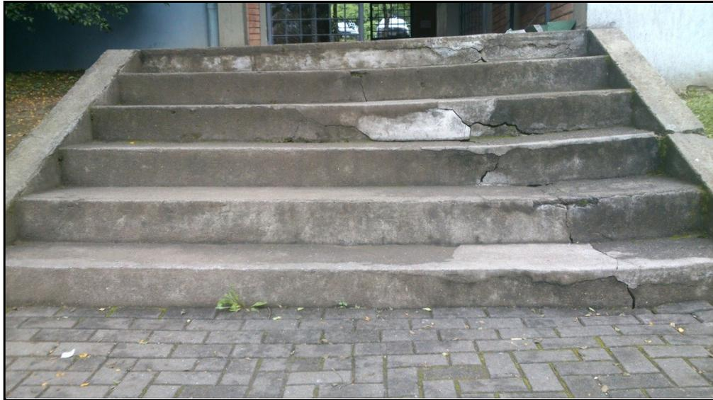
FIGURA 3- OCORRÊNCIA DE TRINCAS E FISSURAS NAS EDIFICAÇÕES CAUSADAS POR COLAPSOS DE SOLO
