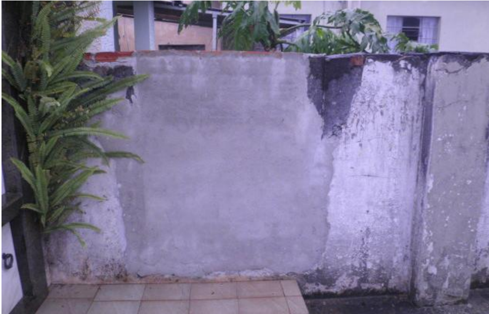
FIGURA 24 – LOCAL ONDE EXISTIA O PORTÃO DE ACESSO A RESIDÊNCIA - CEMITÉRIO BOM JESUS FONTE: Acervo da autora (2013).
