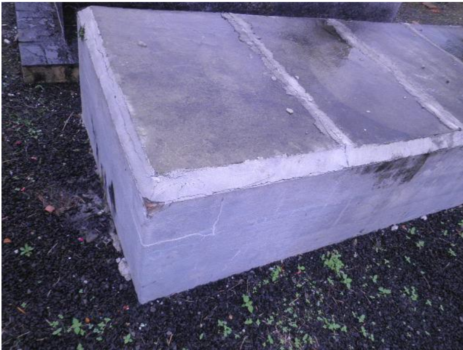
FIGURA 20 – EXISTÊNCIA DE RACHADURAS EM TÚMULO DO CEMITÉRIO BOM JESUS FONTE: Acervo da autora (2013).
