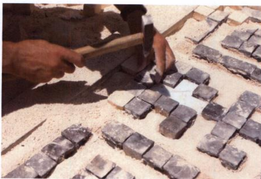
Figura 14: CALCETEIRO COLOCANDO PEDRAS EM FORMA DE QR CODE
