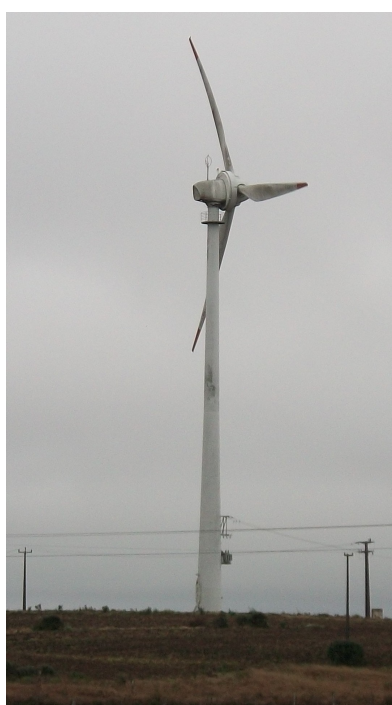
Figura 11 – Aerogerador ENERCON modelo E-40, do parque eólico de Palmas (COPEL)
