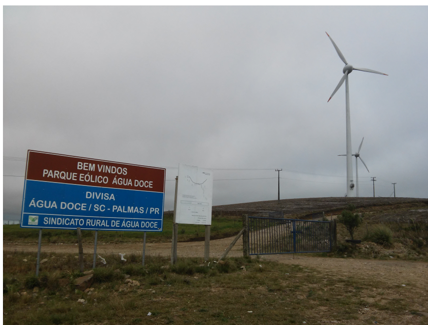
Figura 12 – Entrada do parque eólico de Água Doce (SC), vizinho ao parque eólico de Palmas (PR)
