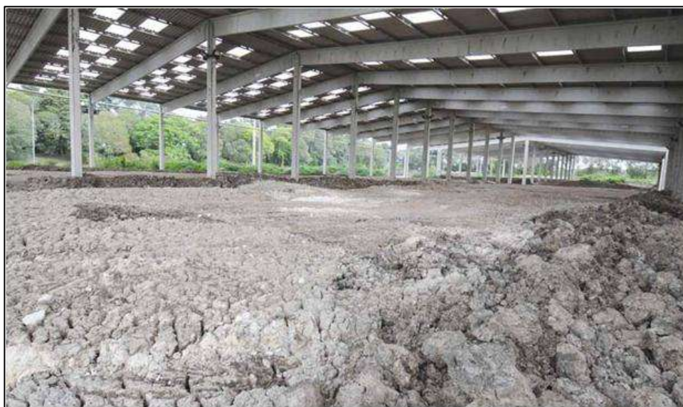
FIGURA 2.4 – PÁTIO DE ESTOCAGEM DE LODO DE ESGOTO CALEADO-ETE BELÉM (SANEPAR), CURITIBA, BRASIL
