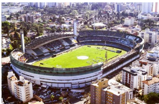
FOTO 22 - COUÇO PEREIRA – VISTA AÉREA 2
