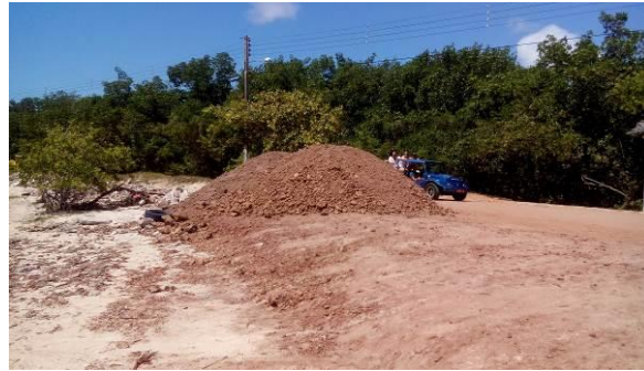
Figura 24 – Retirada da terra em frente às casas em Genipabu – RN
