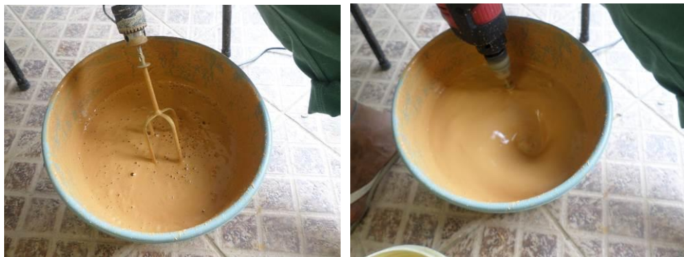
Figuras 35 e 36 – Preparação da tinta com haste de bateadeira e furadeira
