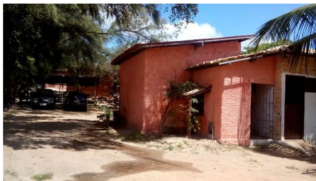
Figura 22 – Casa de pau-a-pique pintada com tinta de terra e goma de cacto
