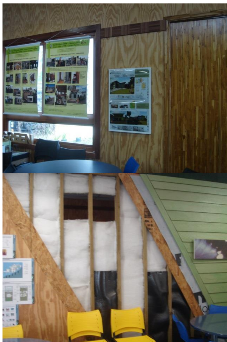
Figura 14- Interior do escritório verde com estrutura em wood frame .
