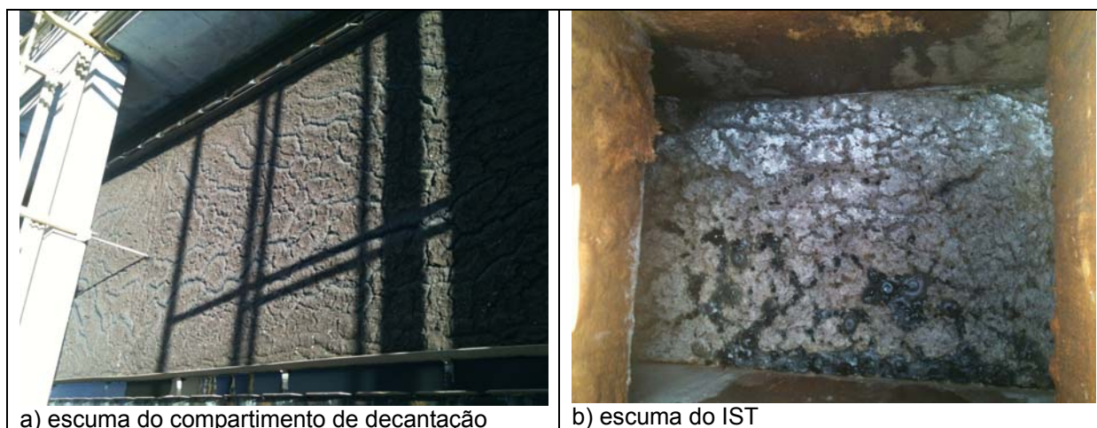
FIGURA 5.7 - DIFERENÇA NO ASPECTO VISUAL DA ESCUMA ACUMULADA NO COMPARTIMENTO DE DECANTAÇÃO E IST DA ETE VASSOURAL (GUARAPUAVA) (JUNHO 2013)
