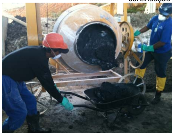
d) descarga da mistura da betoneira.
