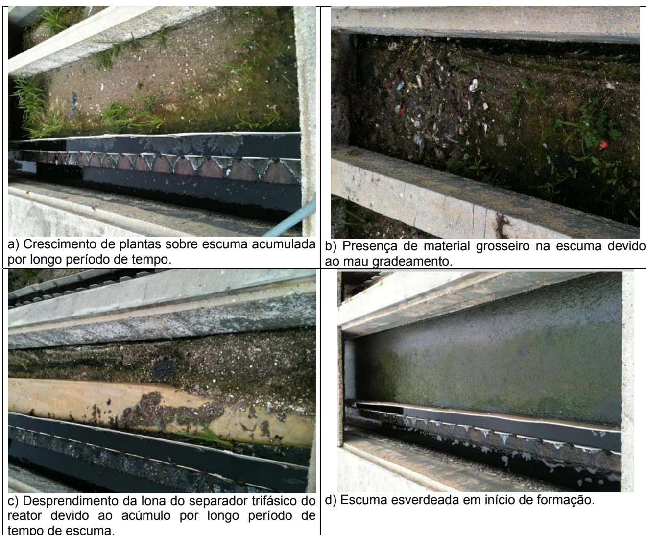
FIGURA 3.11 - ESCUMA ACUMULADA NA SUPERFÍCIE DO DECANTADOR DO REATOR TIPO UASB EM DIVERSAS ETES DA RMC FONTE: O autor (2014)
