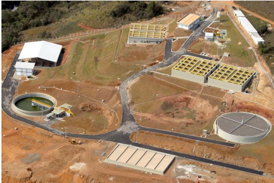
FIGURA 4.3 – FOTOGRAFIA AÉREA DA ETE VASSOURAL EM OBRAS FONTE: Arquivo (2010)
