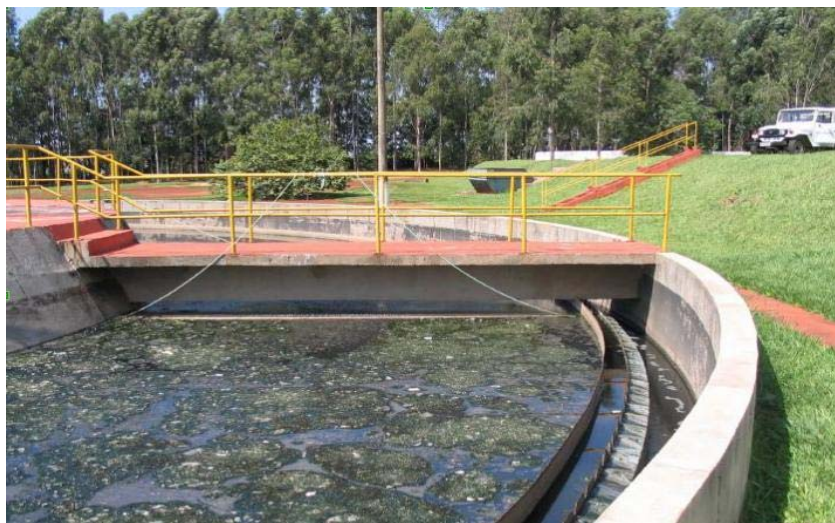
FIGURA 3.10 - ESCUMA ESVERDEADA NA SUPERFÍCIE DE REATOR TIPO UASB ABERTO FONTE: JORDÃO (2005)
