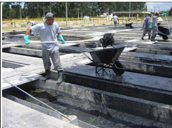
b) Retirada da espuma com pá e carrinho de mão, ETE Atuba Sul (RMC).
