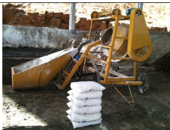
b) betoneira de carregamento automático pronta para recebimento dos produtos
