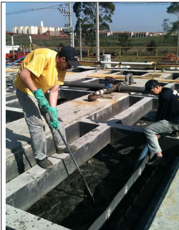
a) Retirada da espuma com sucção para o caminhão limpa-fossa e apoio de rastelo, ETE Padilha Sul (RMC)
