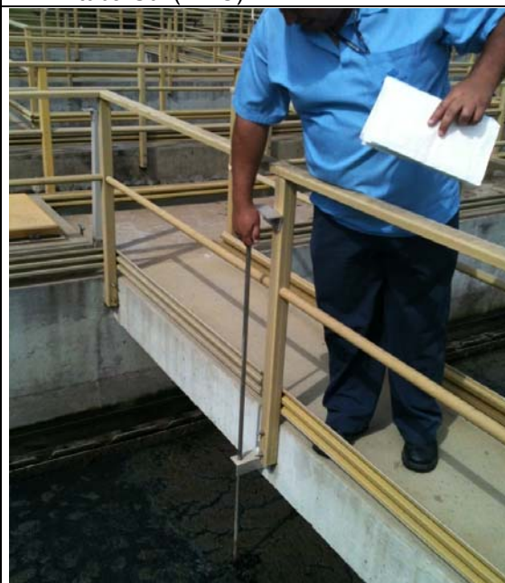
c) Haste para abertura da caneleira de escoamento para retirada de espuma, ETE Vassoural (Guarapuava)
