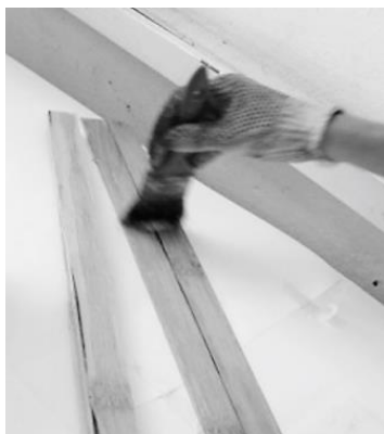
Figura 49: Aplicação de cola nas taliscas Fonte: GIEM (2010).
