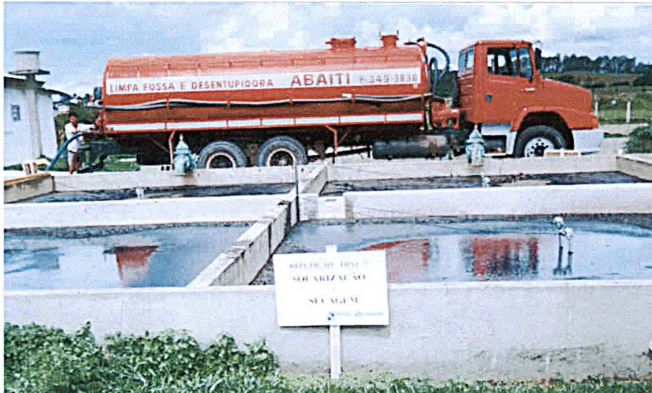
FIGURA 11 – TRANSPORTE E DESCARGA DO LODO POR CAMINHÃO LIMPA-FOSSA
