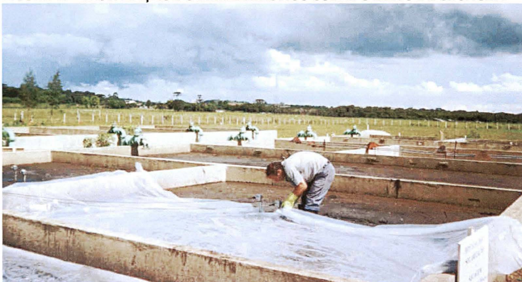
FIGURA 13 – INSTALAÇÃO DO FILME PLÁSTICO SOBRE O LEITO DE SECAGEM
