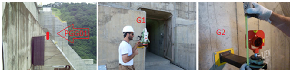
FIGURA 12 - ESTAÇÃO GEODÉSICA NA ENTRADA DA GALERIA NA MARGEM DIREITA E ESTAÇÃO DE VANTE.
