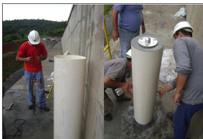
FIGURA 10 - DETALHE DA CONSTRUÇÃO DO PILAR (PGG01) A JUSANTE DA BARRAGEM.
