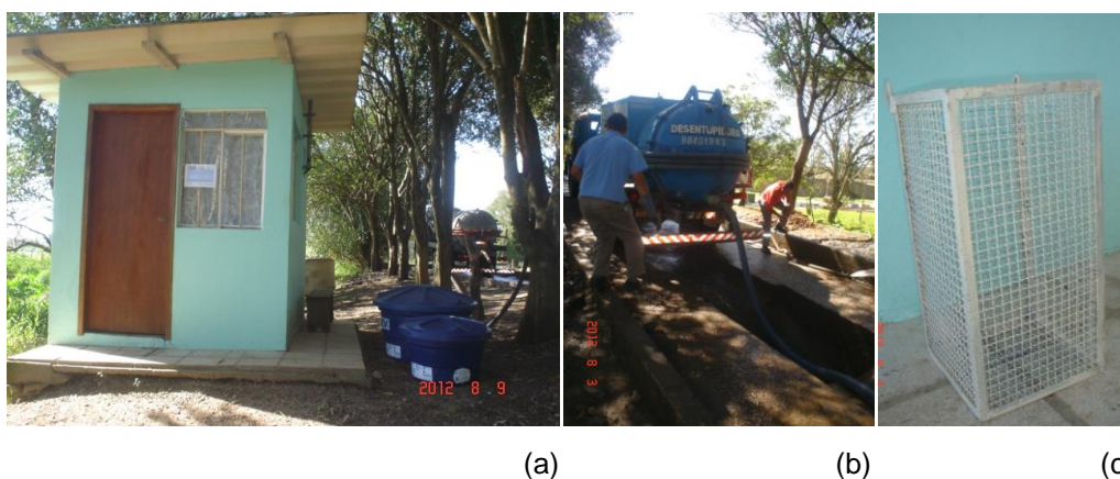
FIGURA 4.2- INSTALAÇÃO EXPERIMENTAL LOCALIZADA NA ETE- BELÉM: (a) EDIFICAÇÃO PARA REALIZAÇÃO DOS ENSAIOS DE SEDIMENTAÇÃO; (b) COLETA DO LODO PARA OS ENSAIOS; (c) GRADE PARA REMOÇÃO DE SÓLIDOS GROSSEIROS
