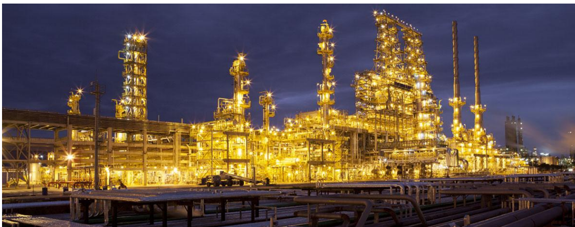
FIGURA 03 - U2200: UNIDADE DE COQUEAMENTO RETARDADO FONTE: Petrobrás (2014) 152
