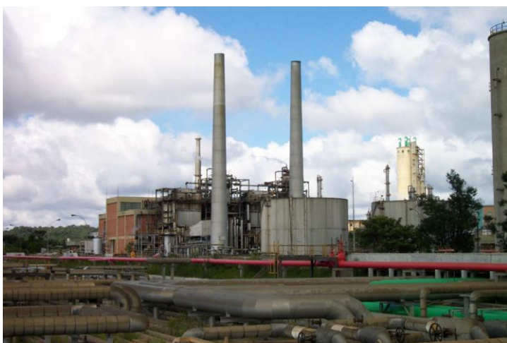
FIGURA 06 - VISTA GERAL DA CASA DE FORÇA DA REPAR FONTE: (CADORIN, 2006, p.55).
