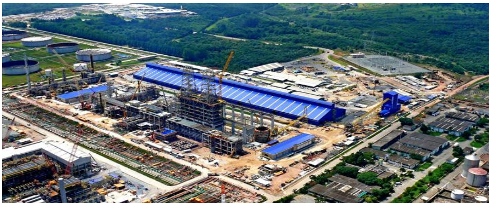
FIGURA 04 - CANTEIRO DE OBRAS FONTE: Petrobrás (2014) 153
