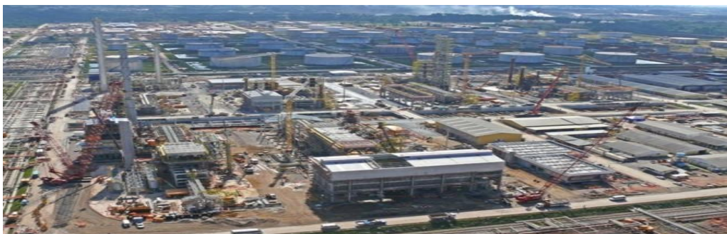
FIGURA 01 - ÁREA INDUSTRIAL E CANTEIRO DE OBRAS DA REPAR FONTE: Petrobrás (2014) 150
