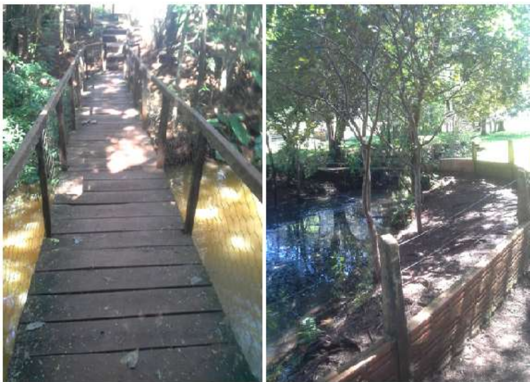
FIGURA 38 - PROTEÇÃO NOS RIOS (PT4) FONTE: Pesquisa de campo (2015)
