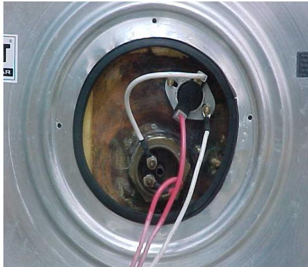
FIGURA 2.12: APOIO ELÉTRICO SIMPLES ACOPLADO AO TANQUE DE ÁGUA QUENTE.
