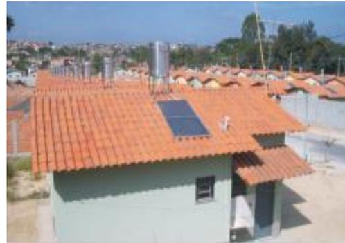
FIGURA 2.9 INSTALAÇÕES POR CONVECÇÃO COM EQUIPAMENTO POPULAR DE LINHA FABRIL DISPOSTO SOBRE O TELHADO DA EDIFICAÇÃO RESIDENCIAL EM BAIXA PRESSÃO DE FUNCIONAMENTO.
