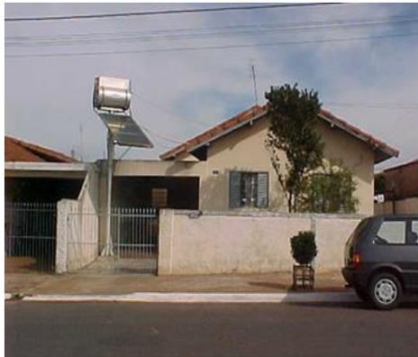
FIGURA 2.31: AQUECEDOR SOLAR DESAGREGADO DO TELHADO DA RESIDÊNCIA.
