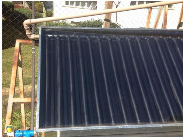
FIGURA 3.7: COLETOR SOLAR DE PLACA PLANA (FPC).
