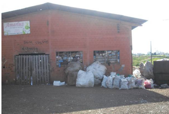
Foto 1: sede da AMARLUZ, associação de catadores de material reciclável, situada no bairro da escola
