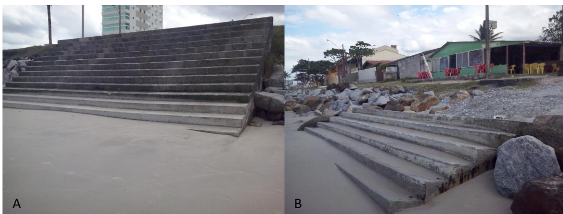
Figura 2: Diferentes escalas nas obras de proteção costeira (escadarias) localizadas no Balneário Caiobá (A) e no Balneário Flamingo (B). Acrescentar em cada foto uma letra conforme a sua identificação na legenda.
