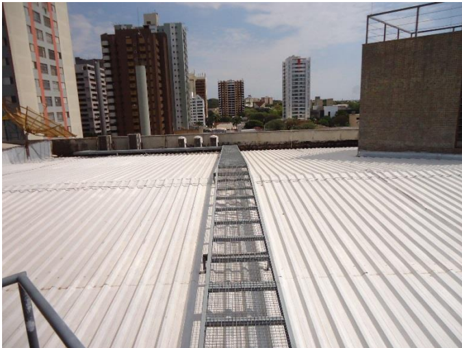
Figura 5: Local para instalação dos coletores solares fotovoltaicos
