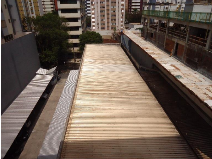
Figura 4: Local para colocação das placas para aquecimento solar
