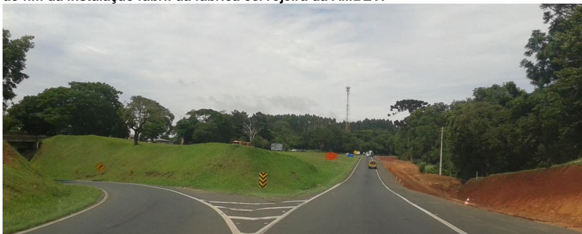
FIGURA 30. Obras de duplicação na BR-376, em Ponta Grossa, que terminam justamente ao fim da instalação fabril da fábrica cervejeira da AMBEV.
