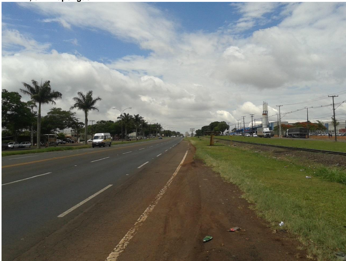
FIGURA 25. Paralelismo das redes de transporte – Rede ferroviária próxima à Rodovia PR-444, em Araçongas.
