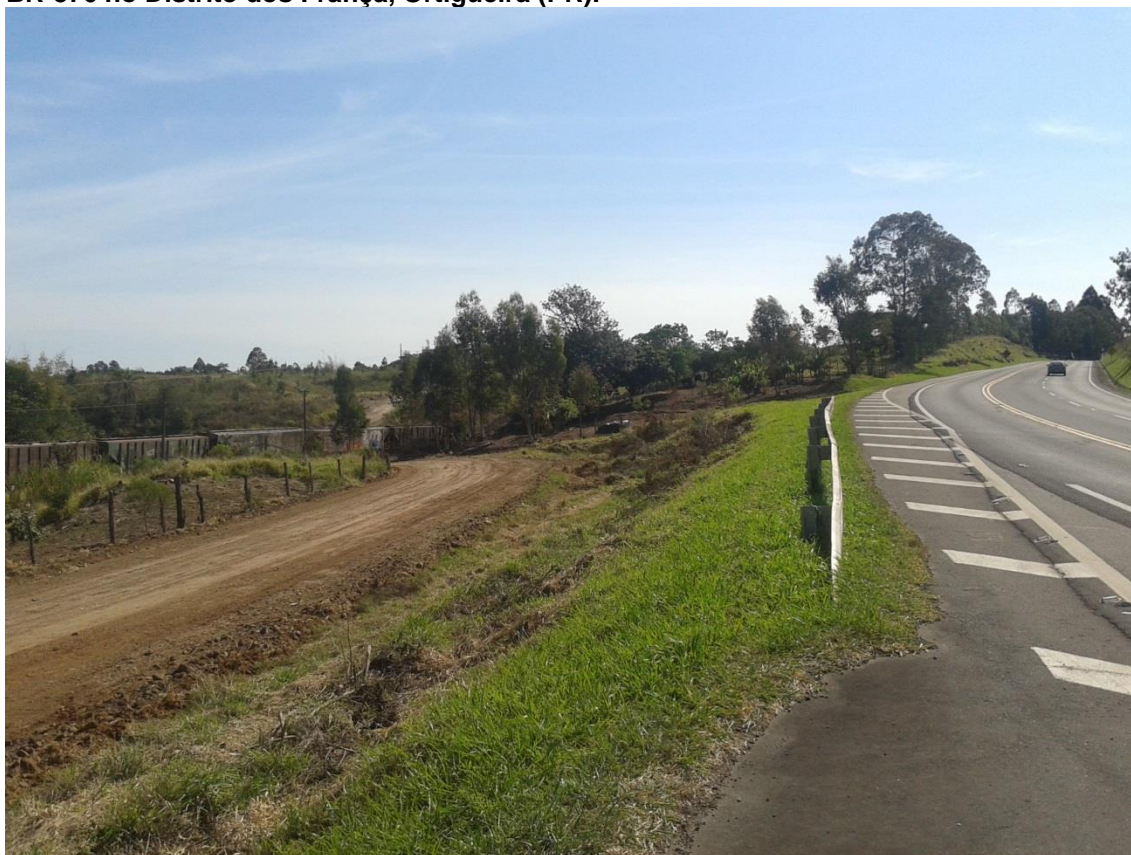
FIGURA 24. Paralelismo das redes de transporte – Rede ferroviária próxima à Rodovia BR-376 no Distrito dos França, Ortigueira (PR).
