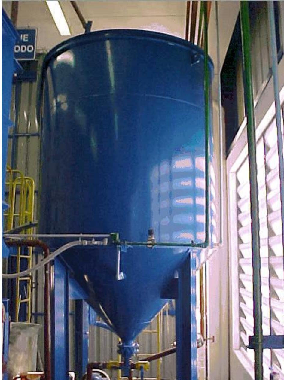
**Figura 6.** Decanter do lodo (fonte: Jonhson Controls)
