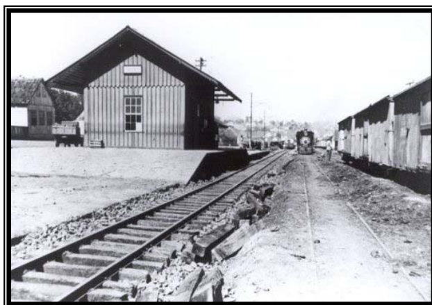
FOTO 01 – Estação original de Irati (sem data) FONTE: GIESBRECHT, 2003.
