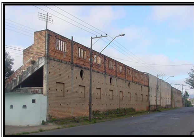
FOTO 07 – Antigo Estádio Ferroviário (União da Vitória)
