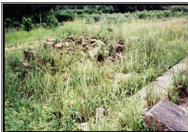
FOTO 45 – Entulhos da extinta estação de Paula Freitas FONTE: LUZ, 2003.
