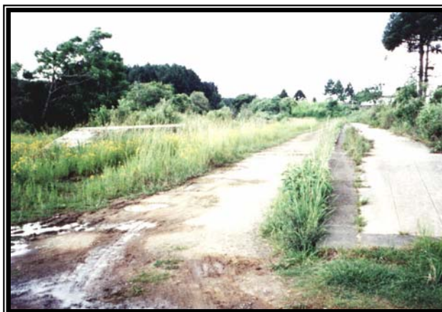
FOTO 42 – Plataforma da extinta estação de Mallet FONTE: LUZ, 2003.
