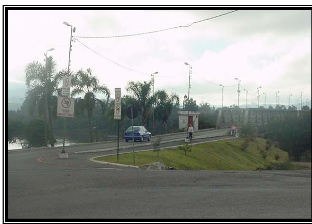
FOTO 14 – Antiga ponte férrea (União da Vitória) 6
