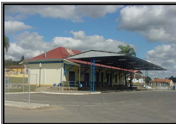
FOTO 34 – Estação de Rio Azul após a reforma (2005)
