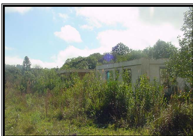
FOTO 31 – Casas ferroviárias abandonadas em Paulo Frontin
