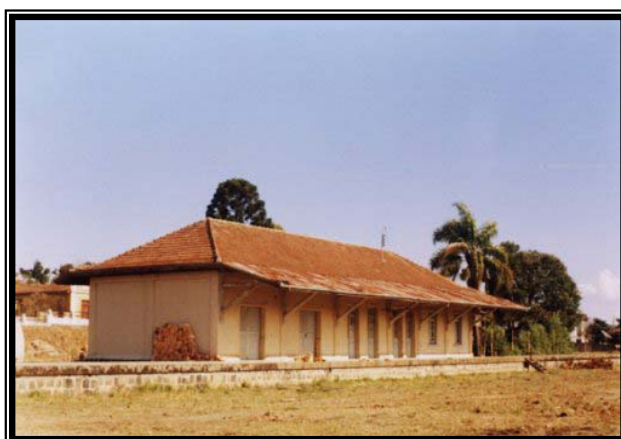
FOTO 33 – Estação de Rio Azul antes da reforma (2001)
