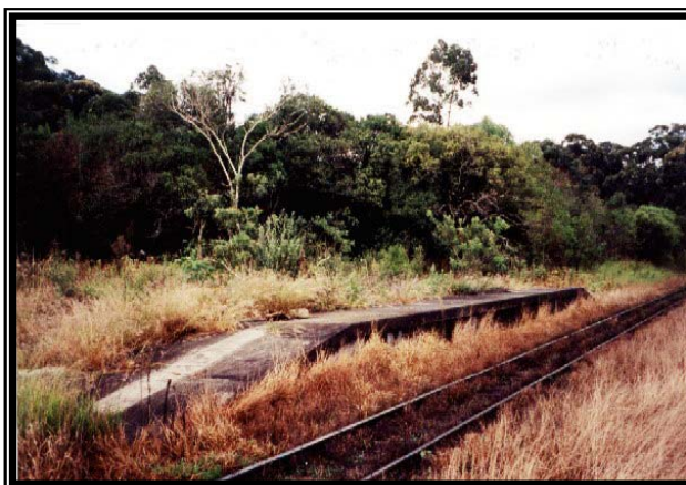
FOTO 38 – Plataforma da extinta estação de Roxo Roiz (Ponta Grossa) FONTE: LUZ, 2003.
