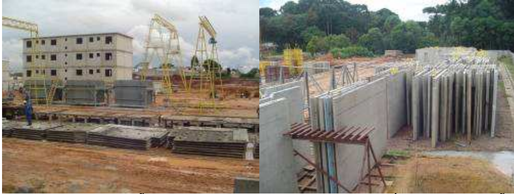
FIGURA 7. EDIFICAÇÃO COM PAREDES DE CONCRETO PRÉ-MOLDADAS, SÃO JOSÉ DOS PINHAIS/PR FONTE: Dados de pesquisa (2011)
