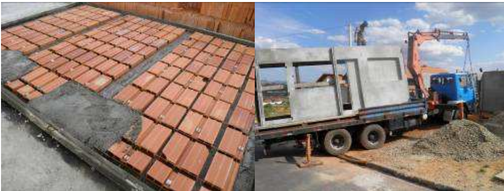
FIGURA 6. CASA COM SISTEMA DE PAREDES PRÉ-FABRICADAS DE BLOCOS CERÂMICOS E CONCRETO, ITAPIRA/SP FONTE: Dados de pesquisa (2011)
