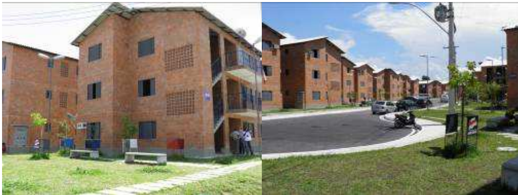
FIGURA 11. EMPREENDIMENTO HABITACIONAL CONSTRUÍDO COM BLOCOS CERÂMICOS ESTRUTURAIS, MANAUS/AM
