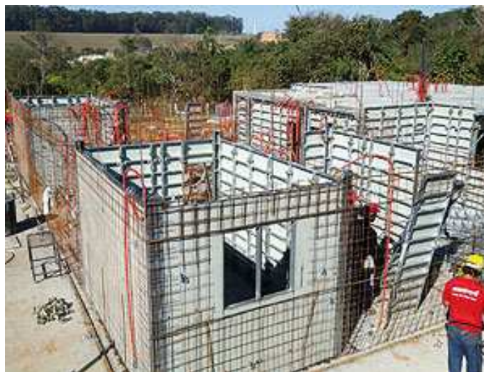
FIGURA 13. CASA SENDO CONSTRUÍDA COM PAREDES DE CONCRETO MOLDADAS NO LOCAL – CIA.CASA SISTEMAS CONSTRUTIVOS
