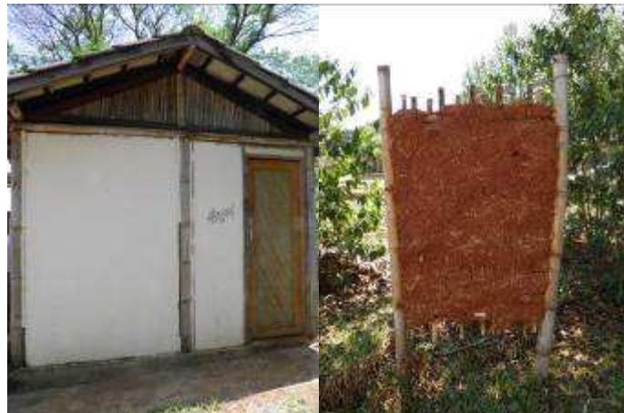
FIGURA 2. CASA COM PAREDES DE FIBRAS DE BAMBU, CAMPINAS/SP FONTE: Dados de pesquisa (2011)
