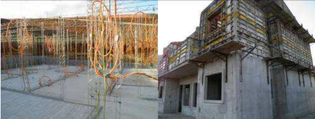
FIGURA 5. EDIFICAÇÃO EM PAREDES DE CONCRETO MOLDADAS NO LOCAL, SÃO JOSÉ DOS CAMPOS/SP FONTE: Dados de pesquisa (2011)
