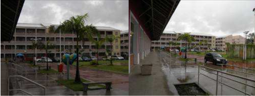
FIGURA 10. EMPREENDIMENTO HABITACIONAL CONSTRUÍDO COM BLOCOS DE SOLO-CIMENTO APARENTES, NA COMUNIDADE DE MANGUINHOS, RIO DE JANEIRO/RJ
