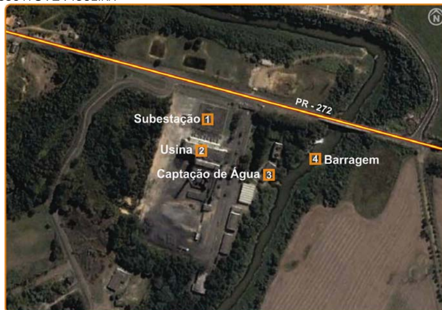
FIGURA 6: ACESSO À UTE FIGUEIRA
