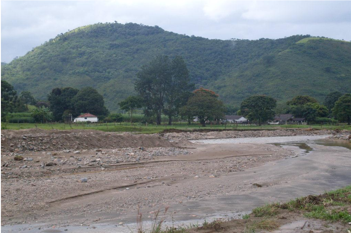
Figura 21: Grande acúmulo de sedimentos no leito do Ribeirão Gomerl, no seu setor de jusante, ocasionado pelo uso e ocupação indevido da APP de vegetação marginal e atividades antrópicas potencializadoras de processos erosivos a sua montante. Fonte: Pablo Nepomuceno, 2011.
