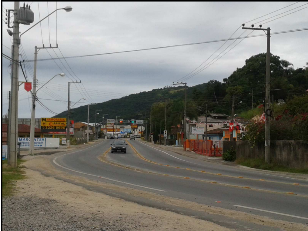
Figura 7 - Vista parcial 01 da SC-405 próximo ao acesso da ETE Campeche (10/06/2012).
