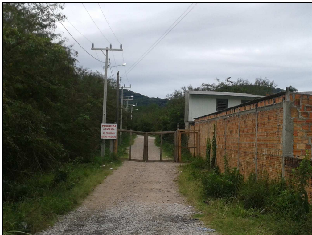
Figura 6 - Vista parcial do acesso ao terreno da ETE Campeche (10/06/2012).
