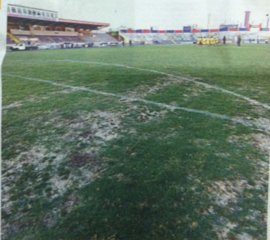
Solução encontrada para nivelar o gramado, colocar areia nos buracos piorou o aspecto do terreno e não minimizou o problema.
