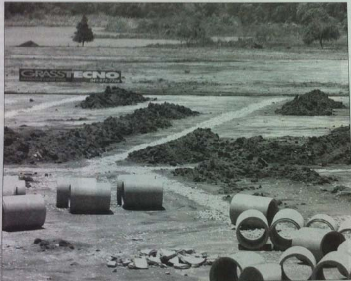
Imagem de 2002 mostra o terreno em Quatro Barras onde o Paraná pretende construir o CT. Início imediato das obras.
