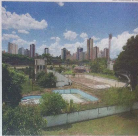
Estado deplorável das piscinas na Vila Capanema simboliza a penúria financeira do Paraná.
