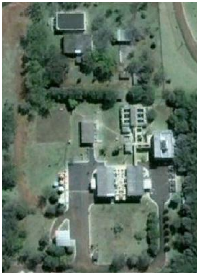
Figura 09 - ETA Vila C
