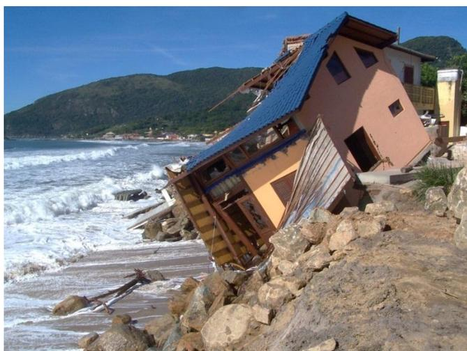
FIGURA 21 - EROSÃO COSTEIRA DEVIDO A RESSACA NA PRAIA DA ARMAÇÃO EM FLORIANÓPOLIS EM 2010
